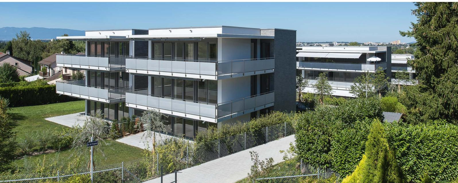
Les détails bien étudiés et la mise en œuvre soignée cachent un système constructif avec structure en béton armé. L'isolation périphérique se voit simplement crépie ou, pour les murs pignons, recouverte de grès cérame.
